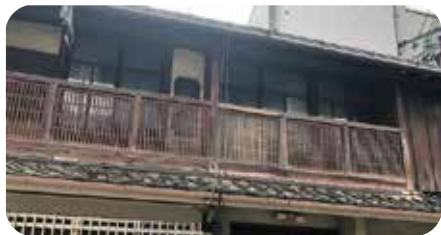
かつての建物の面影が今も残る(2階部分のみ)
